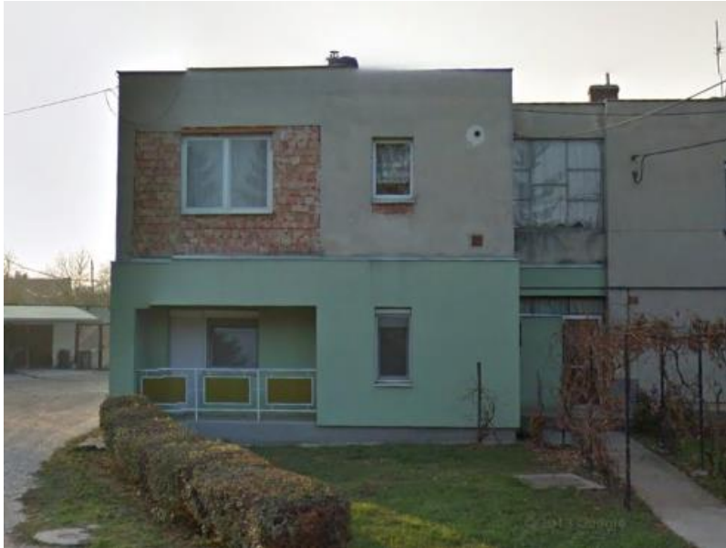
Társasháznál egyedileg megvalósított homlokzatszigetelés, bővítés
