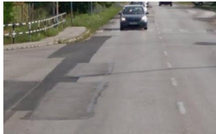
Az úthelyreállítás hibái, eltérő színű burkolatok
