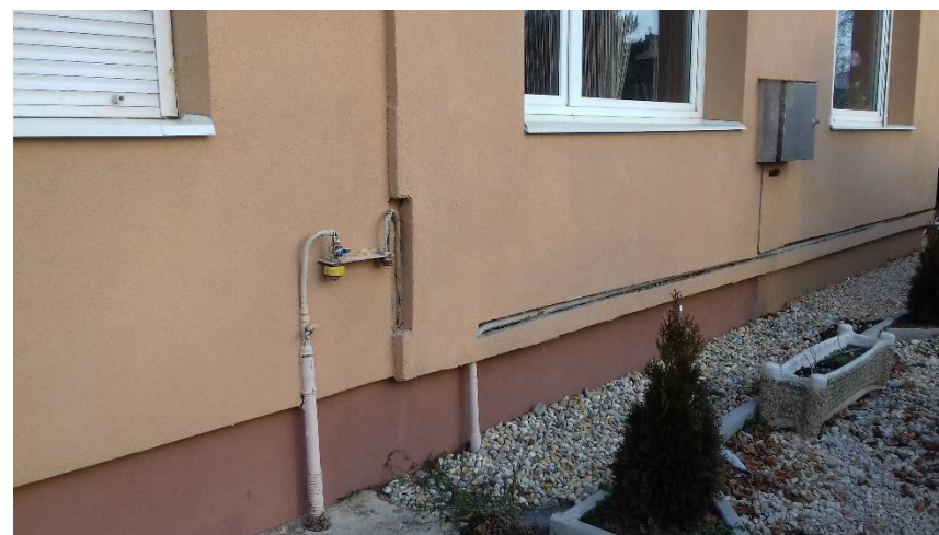
Utólagos hőszigetelés a gázvezeték kihagyásával
