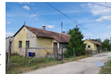
< Ikerház Sinatelep-Újtelepen, a Madách utcában, modernizált házrész, beépített tornáccal
