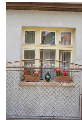
Felújítás során megtartott szép régi ablak (Arany J. u.)
