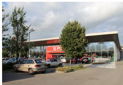
< A SPAR áruház korszerű megjelenésű kereskedelmi épülete
