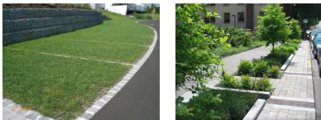
Példaértékű útszegély és árokkialakítás
