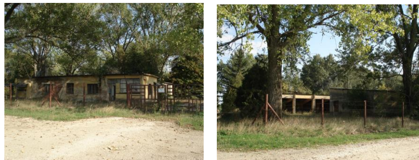
A Duna-parti honvédségi terület „fogadóépülete” és a használaton kívüli gazdasági épületek
