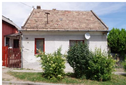
Utcafronta épült, zárt sorú beépítésű, tagolt párkányú ház a Fő utcában >
