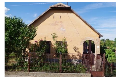
< Teljes kialakításával eredeti állapotát őrző lakóház az egykori főúton (Dózsa György út). Az épület jelenleg lakatlan, elhanyagolt.
