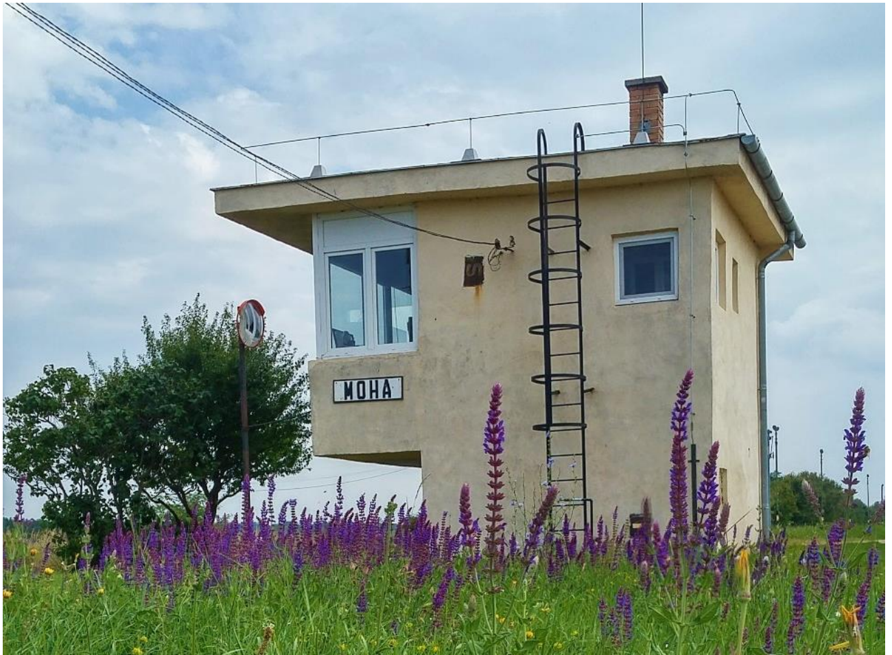
MOHA VASÚTI MEGÁLLÓHELYE
