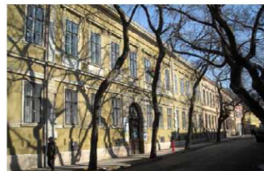
ADY ENDRE UTCA 9.-15. LAKÓHÁZ védelmi (bírság) kategória: III. törzsszám 1473 hrsz: 151/2,3,5,6,7, azonosító: 3805 A XIX. szd. végén épültek a házak, a 13. sz. alatti csendőrpáncsnokság céljára. 1980-84-ben az ÁREV irodai célra teljesen átalakította (Zalka István). A telek északi végében lábakra állított, CLASP-rendszerű ház, alatta a városfal egy szakasza bemutatva. 2007-2008-ban a 15. sz. épületet teljesen felújították (Tóth Zsuzsa), a többitől leválasztották. GPS koordináták: 47°19'36.68"N / 18°40'70.35"E műemléki környezet (hrsz): azonosító: -
