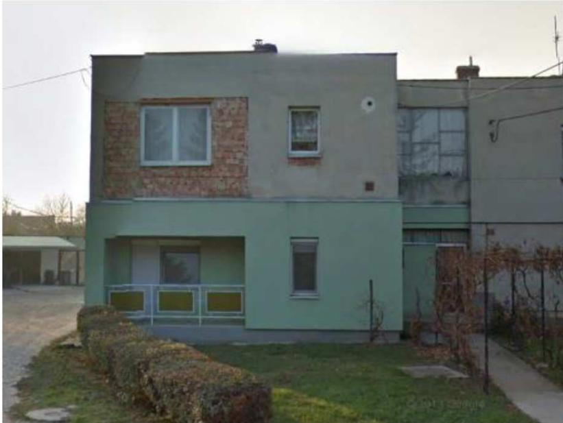
Társasháznál egyedileg megvalósított homlokzatszigetelés, bővítés
