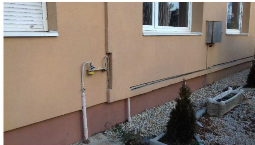
Utólagos hőszigetelés a gázvezeték kihagyásával
