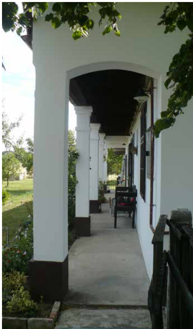
Hagyományörzően felújított ház Száron
