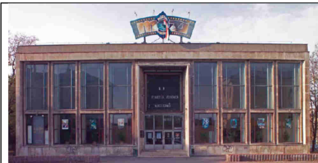
forrás: Dunaújváros Építészeti Kalauz 1950-1960
